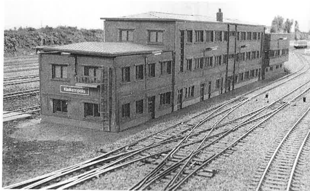
Le bâtiment administratif de Kinkempois Photo André Mertens
